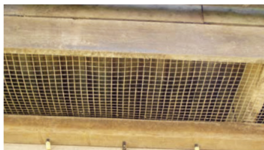
Bild 5. Rengjort nät vid takfot.
