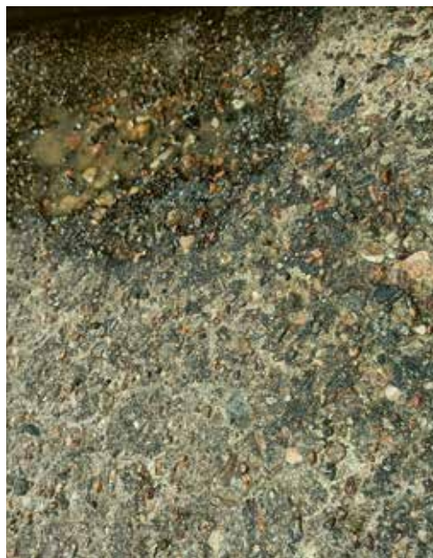
Slitna golv är svåra att få rena och torra. Kvarbliven fukt och ojämnheter gynnar smittämnens överlevnad.
