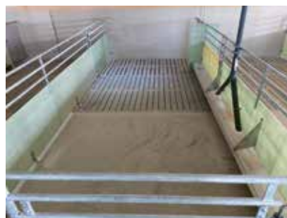
Exempel på en tvårträgsbox där en del av liggytan utgörs av urindränerande miljöspalt. Foto: SKIOLD.
