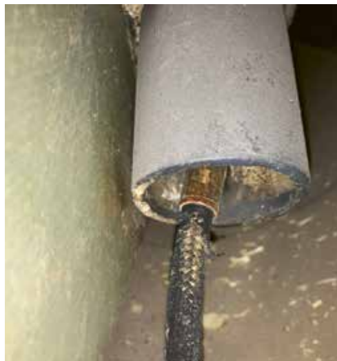
Tvättiller används vid rengöring av nedsläppsrör över trägen
