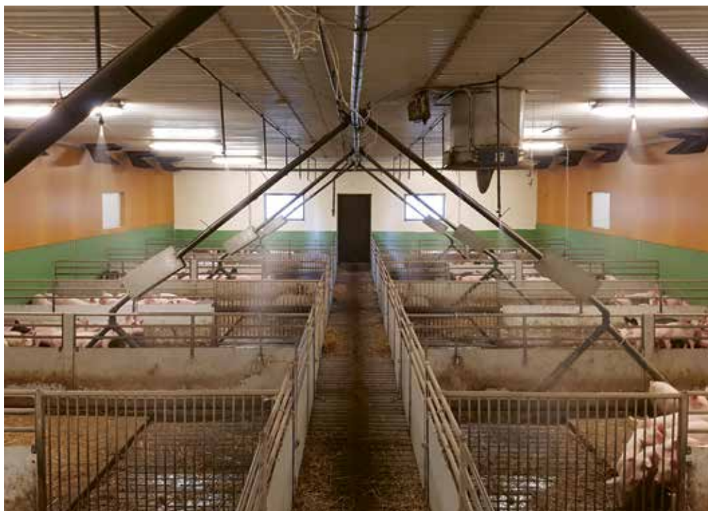
Tvärågsstall med dusch över gödslingsytan. Foto: SLU.
