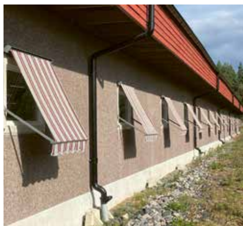
Markiser hindrar direkt solinstrålning och minskar solvärmelasten genom fönstren.
