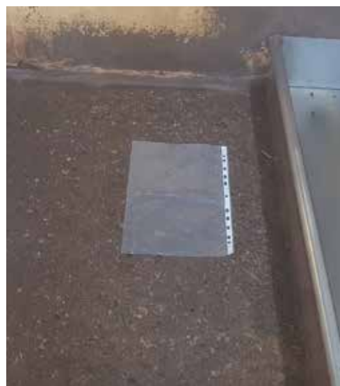
Efter upptorkning och tomperiod kan en plastficka användas för att kontrollera att golvet är tillräckligt torrt.
