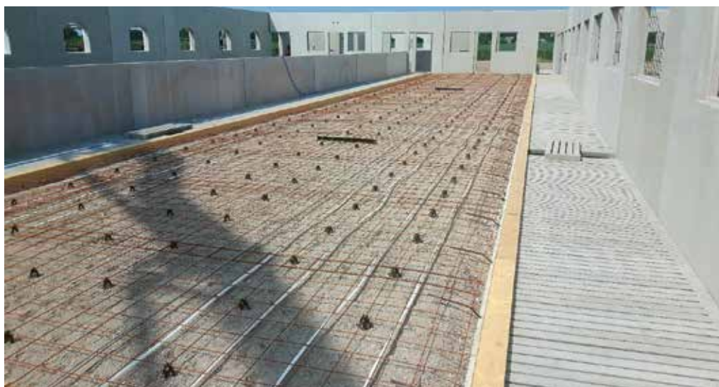
Markbädd med armering och golvvärmeslang inför gjutning av golv till ett slaktgrisstall. Mer om markarbete, armering och gjutning finns i bilaga 3. Foto: Heidelberg Materials.
