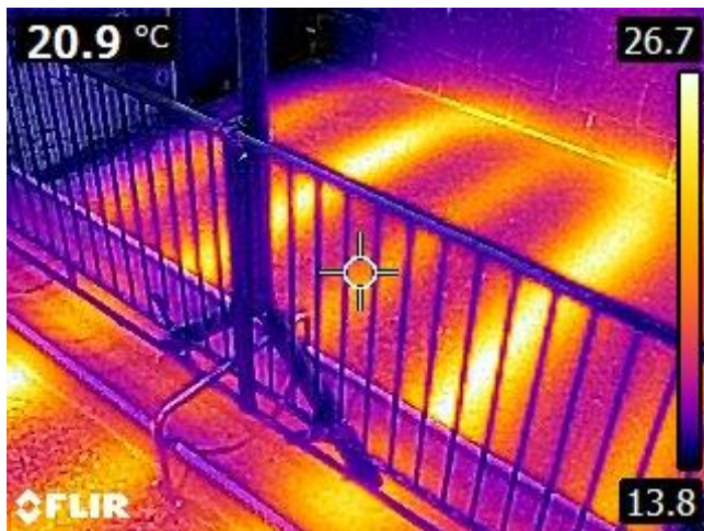
Figur 4. Golvvärmeslangarna i bes 2.
