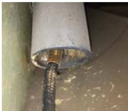
Tvätta av fodernedsläppsrör med så kallad iller.
