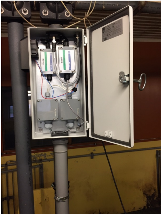
Figur 2. I miljöstationen finns sensorerna för koldioxid, ammoniak, temperatur och luftfuktighet. Genom röret nertill suggs luft in av en fläkt. Detta rör sattes alltid upp 50 cm över golvet.
