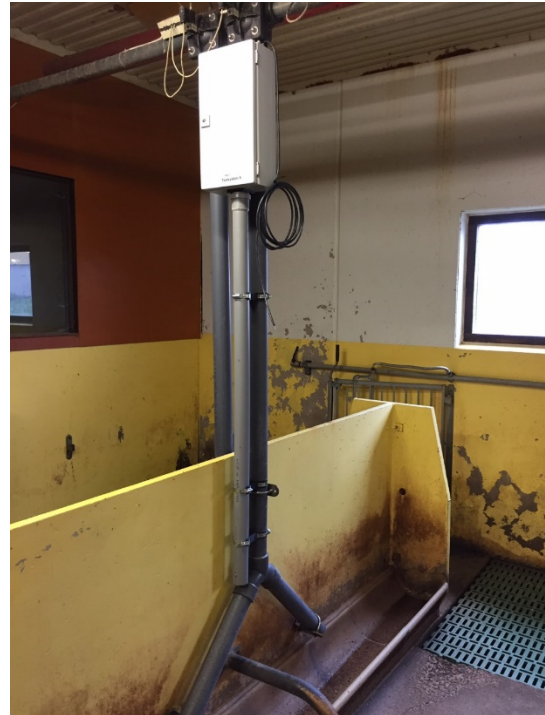
Figur 3. Miljöstationen i besättning 1, placerad i enhetsbox.
