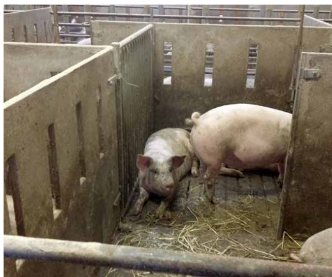
Bild 7. Perforerade betongväggar (se även bild 1) medger luftförelser som kan ge svalka.
