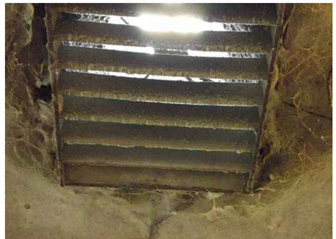
Bild 8. Ett kraftigt nersmutsat spjäll medför kraftigt minskad funktion.
