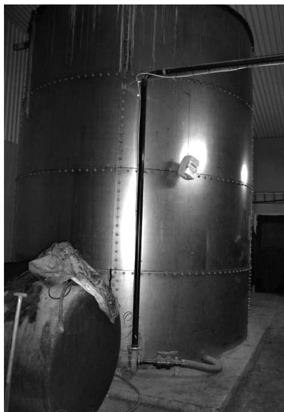
Bild 3) Stående lagringstank för vassle/dränk med propeller i botten för omröring.
